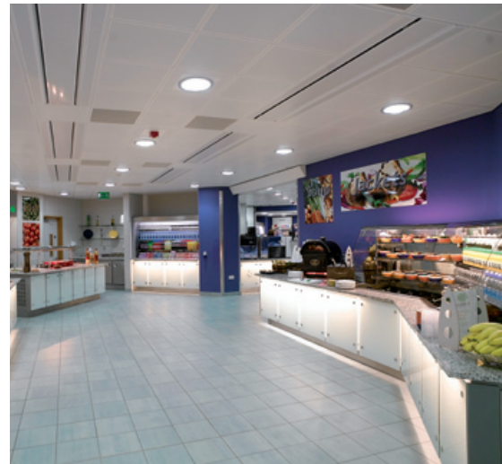
Eladótér. A klímagerendás rendszerek előnye, hogy a szükséges mennyiségű friss levegős szellőztetést is magában foglalja
